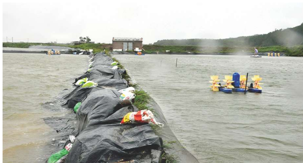
Hình 5: Gia cố bờ bao tại ao, đầm nuôi trồng thủy sản
